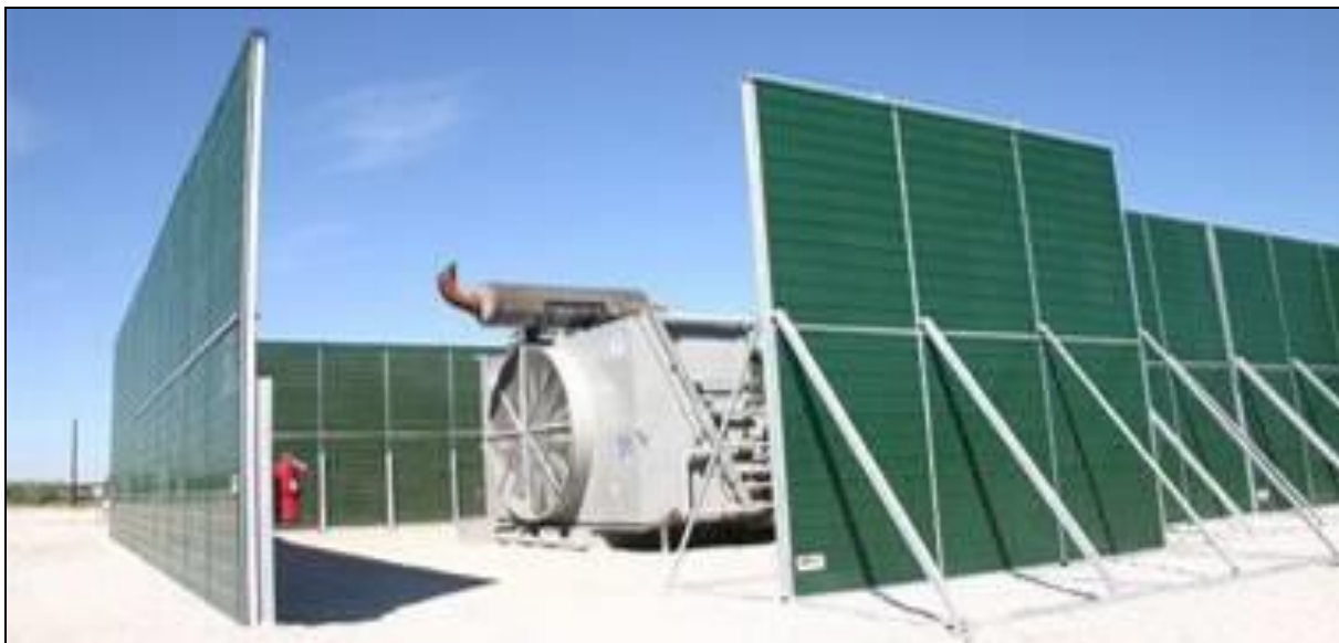
Εικόνα 9-1: Παράδειγμα χρήσης ηχοπετασμάτων σε σταθερές πηγές θορύβου
