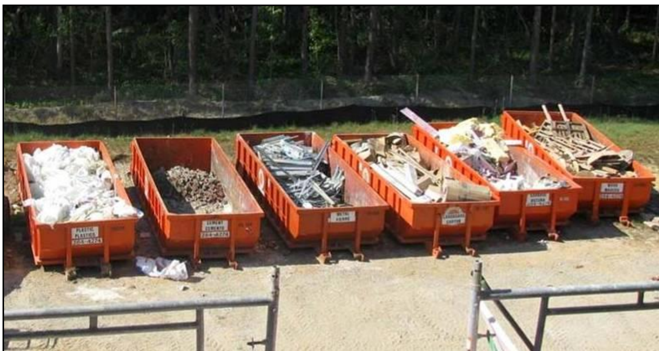
Εικόνα 9-3: Παράδειγμα διαχωρισμού αποβλήτων στο εργοτάξιο
