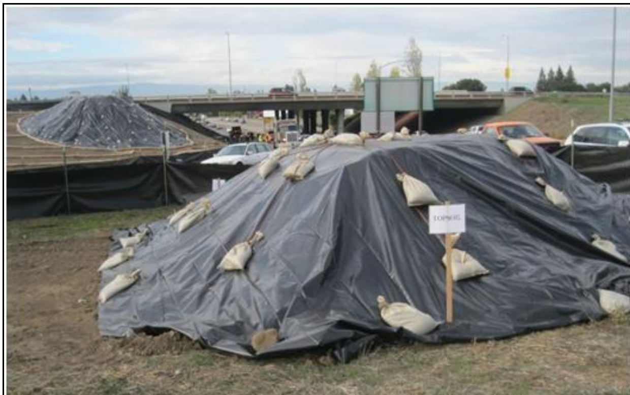
Εικόνα 9-2: Παράδειγμα κάλυψης μπαζών/αδρανών στο εργοτάξιο
